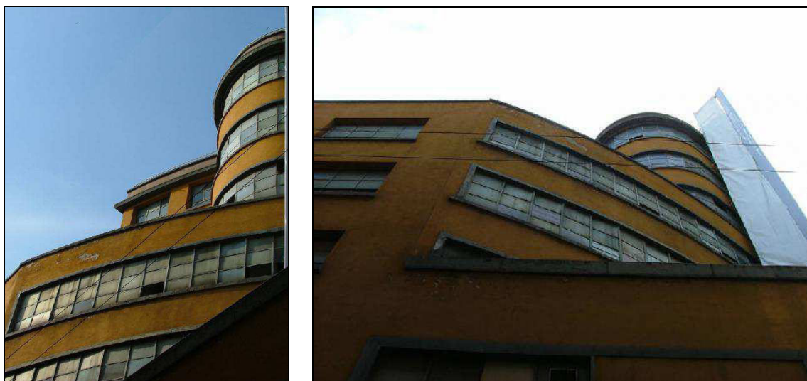
Scorci del fronte principale con la facciata curva
