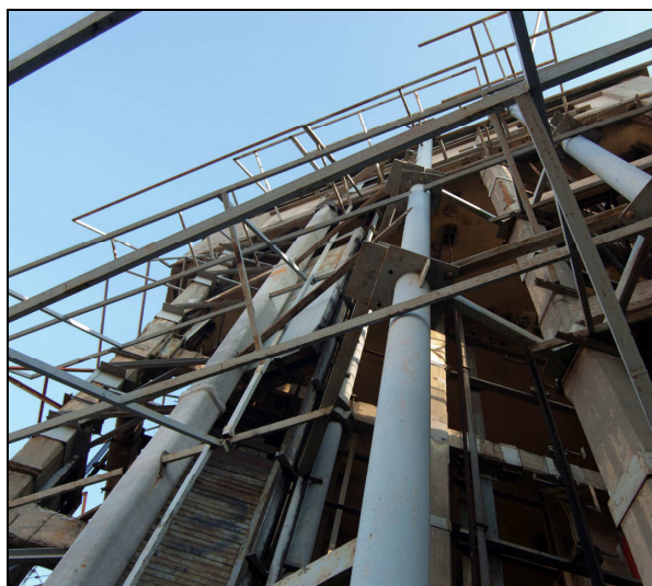
Monta vetture - Struttura a gabbia in cemento armato
