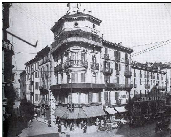
Angolo Venezia-Monforte prima delle demolizioni
