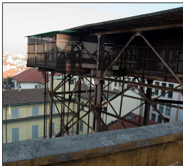
Monta vetture - Struttura a gabbia in metallo
