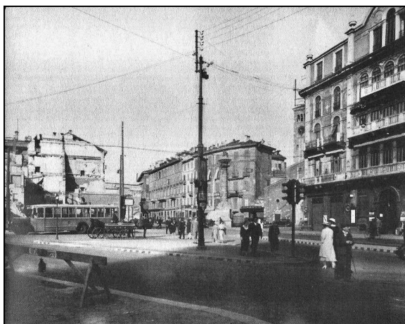
Angolo Venezia-Monforte dopo le demolizioni
