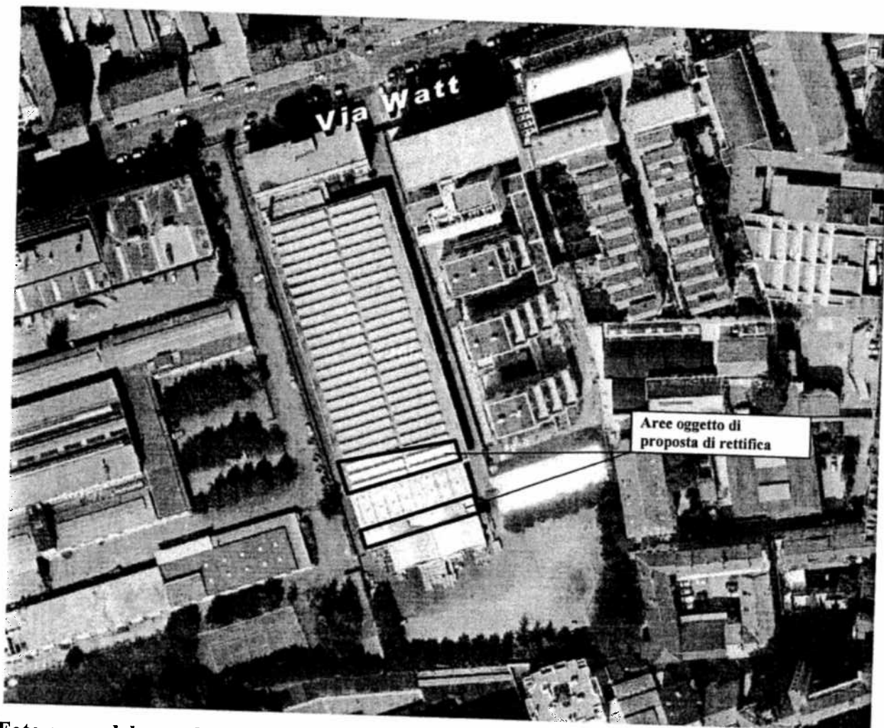
Foto aerea del complesso industriale di via Watt,15
