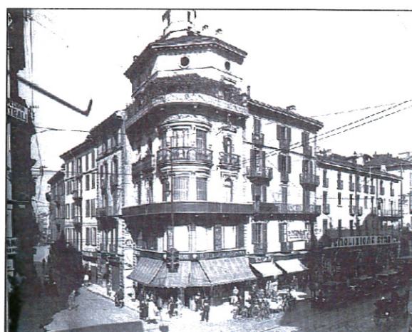
Angolo Venezia-Monforte prima delle demolizioni
