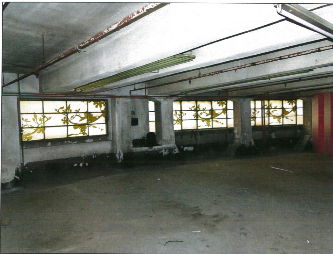
IMMAGINE N.21 - INTERNO PIANO TERZO – FRONTE PRINCIPALE
