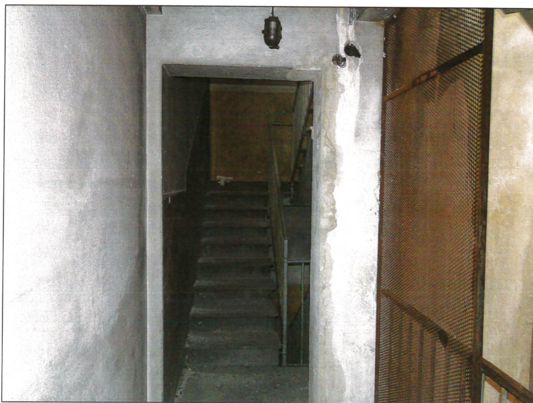
IMMAGINE N.26 - INTERNO - SCALA LATO MONTA VETTURE
