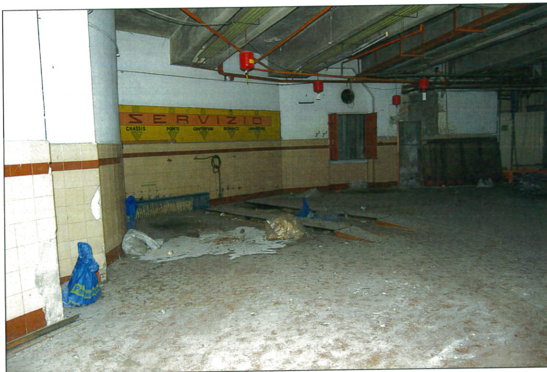
IMMAGINE N.19 - INTERNO PIANO INTERRATO - ZONA STAZIONE DI SERVIZIO
