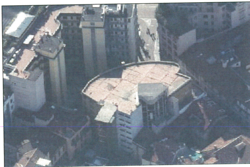
Visione panoramica dei fronti interni dell'autorimessa
