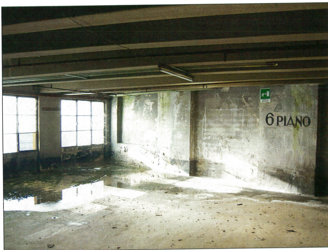
IMMAGINE N.23 - INTERNO PIANO SESTO - PARETE LATERALE CIECA
