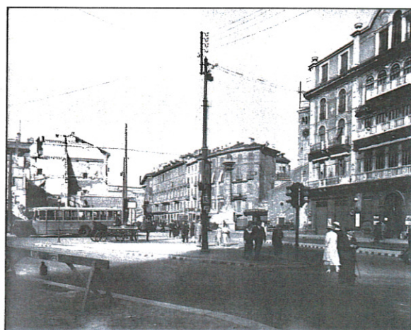
Angolo Venezia-Monforte dopo le demolizioni
