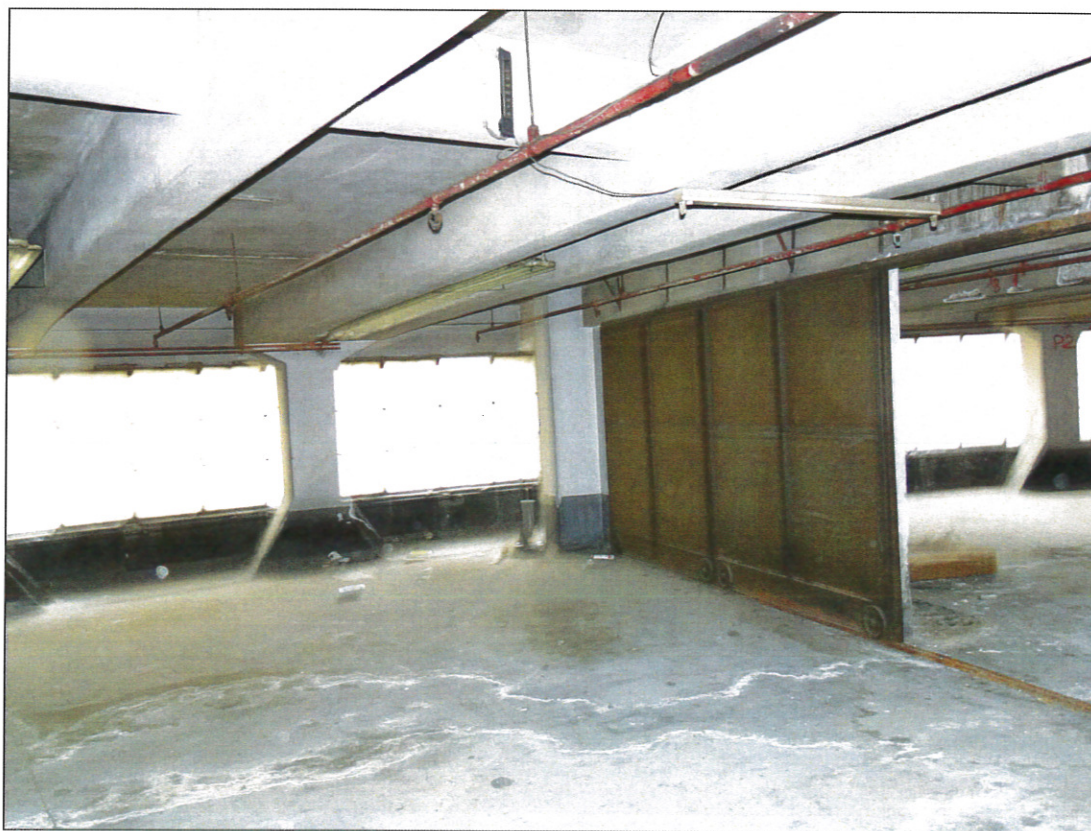
IMMAGINE N.22 - INTERNO PIANO QUARTO - PARATIA ANTINCENDIO
