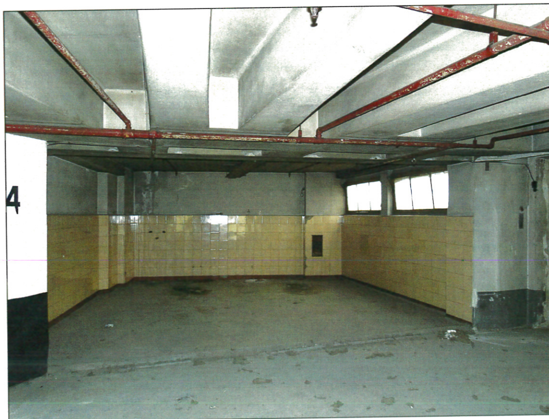
IMMAGINE N.20 - INTERNO PIANO QUARTO - ZONA LAVAGGIO AUTO
