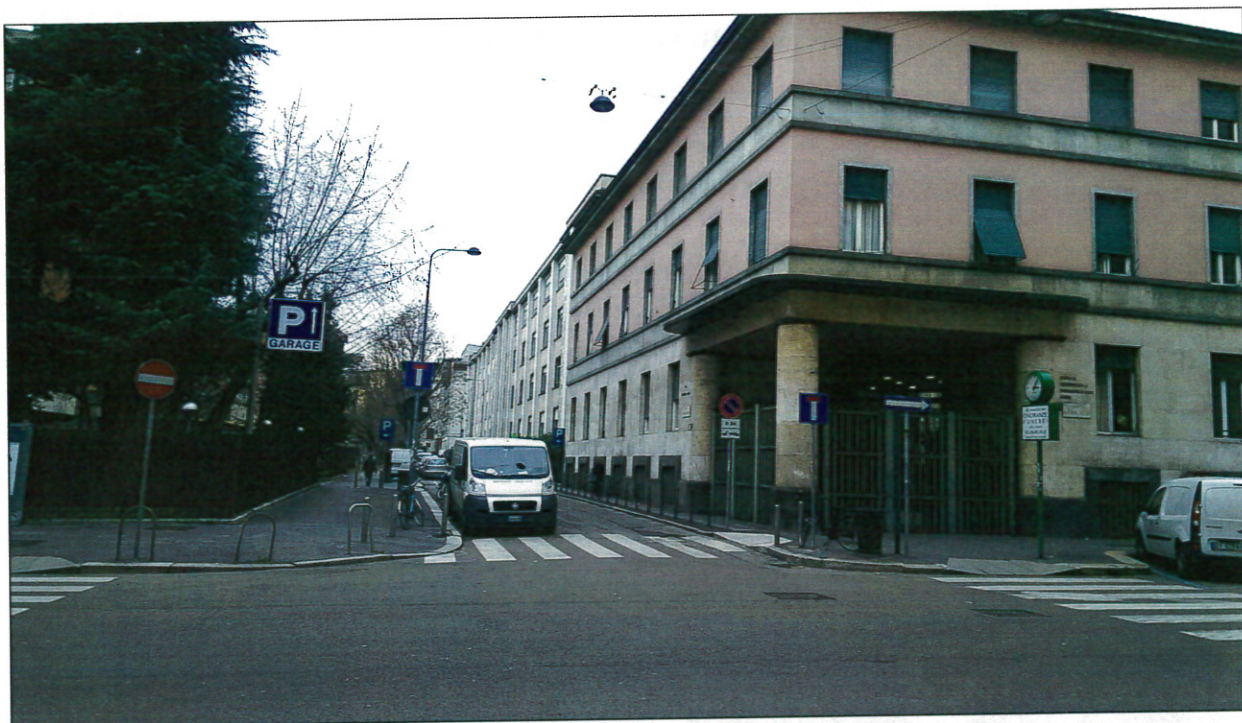
INGRESSO DA CORSO DI PORTA NUOVA
