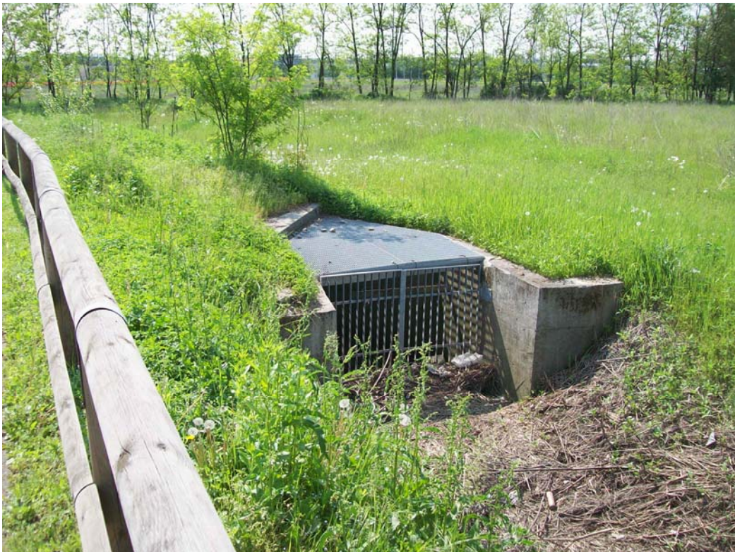
Figura 6 - la griglia per l'attraversamento di via Belgioioso del fontanile Taiolo prima dell'immissione nel cavo Viviani
