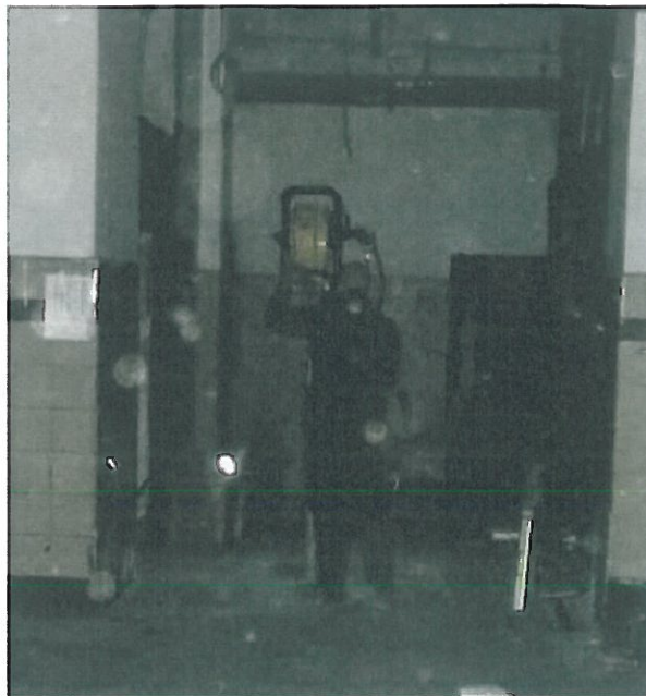
Figura 3.2 – Esecuzione microsondaggi
