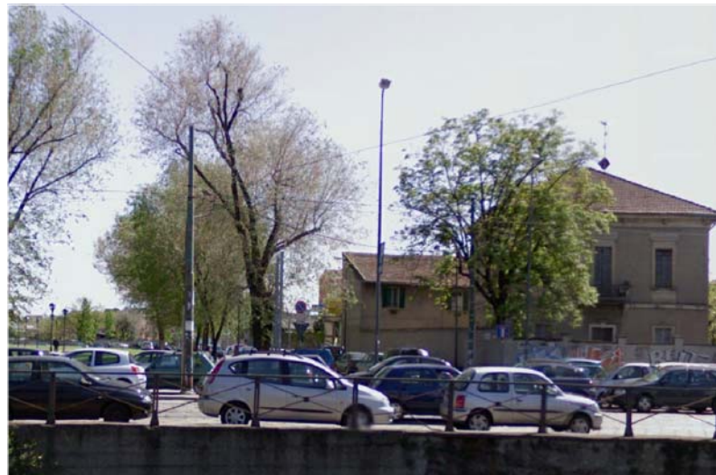
F VISTA DEGLI EDIFICI N.8 E 9 DA RIPA DI PORTA TICINESE E DELLA VIA E.BARSANTI VISTA DI SCORCIO
