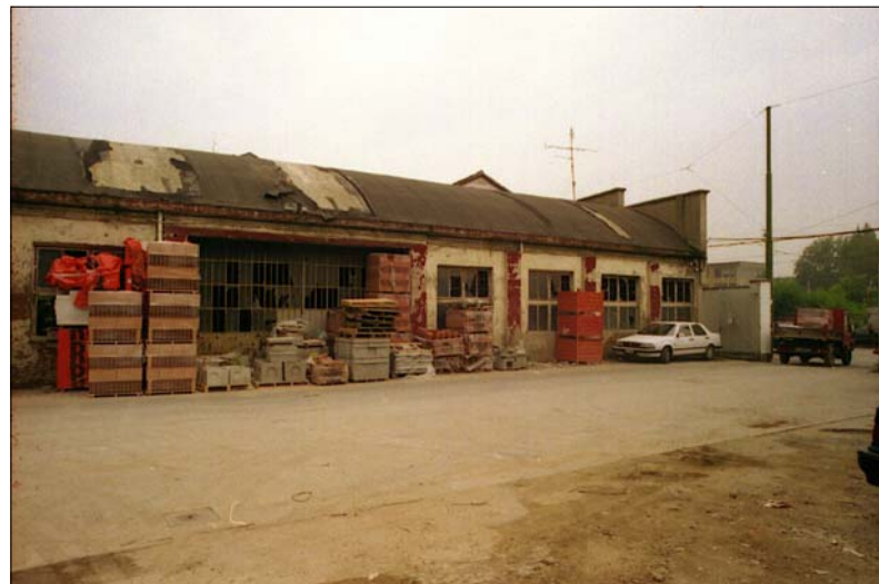
T VISTA DEL CAPANNONE N.10 DALL'INTERNO DELL'AREA
