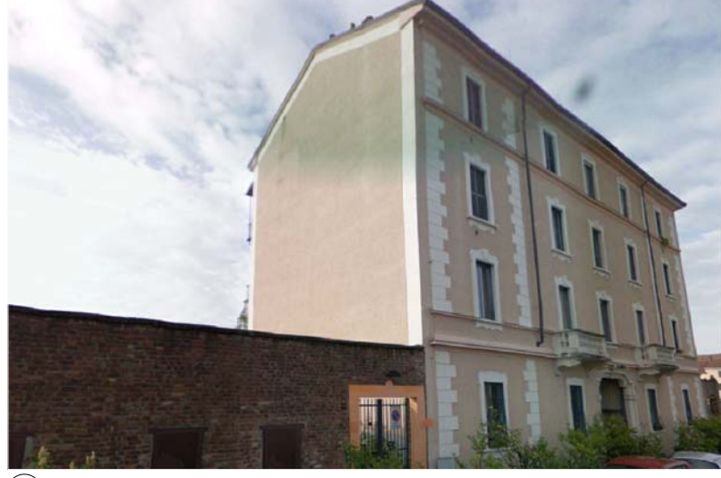
Q VISTA DELL'EDIFICIO N.4 DA VIA AUTARI
