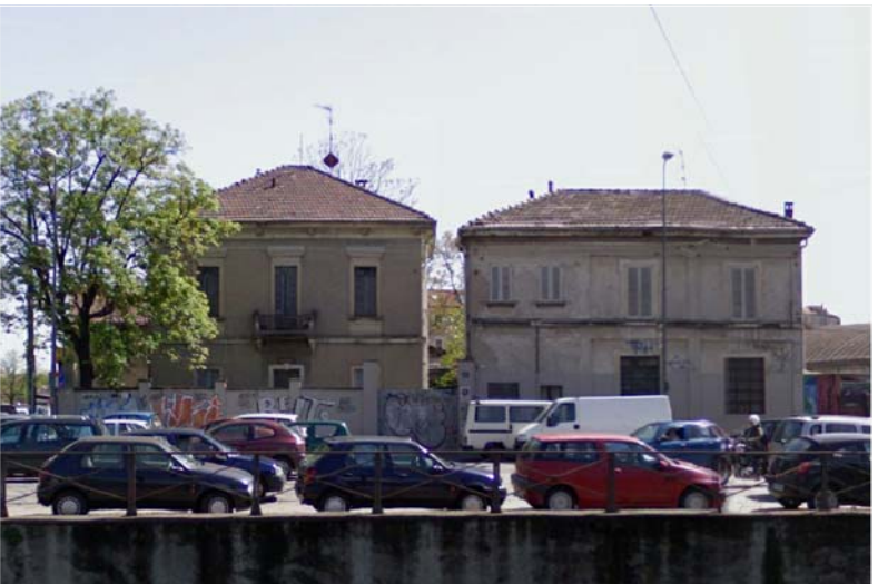
E VISTA DEGLI EDIFICI N.8 E 9 DA RIPA DI PORTA TICINESE
