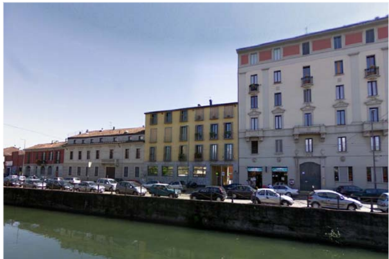
A VISTA DELL'EDIFICIO N.14 DA RIPA DI PORTA TICINESE
