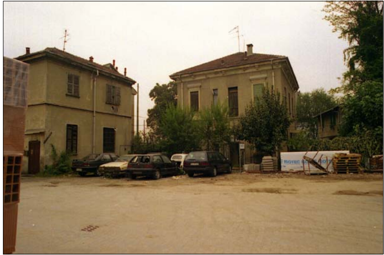
S VISTA DELL'EDIFICIO N.8 E 9 DALL'INTERNO DELL'AREA
