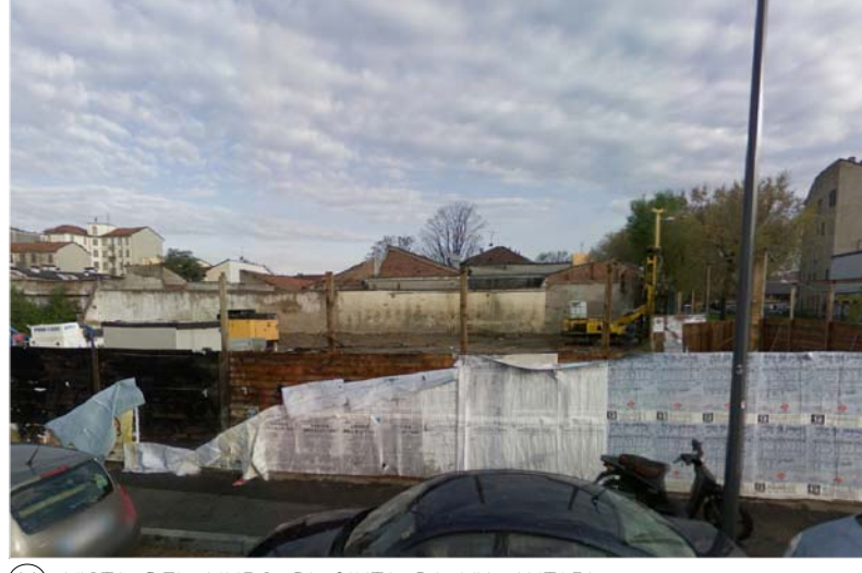
N VISTA DEL MURO DI CINTA DA VIA AUTARI
