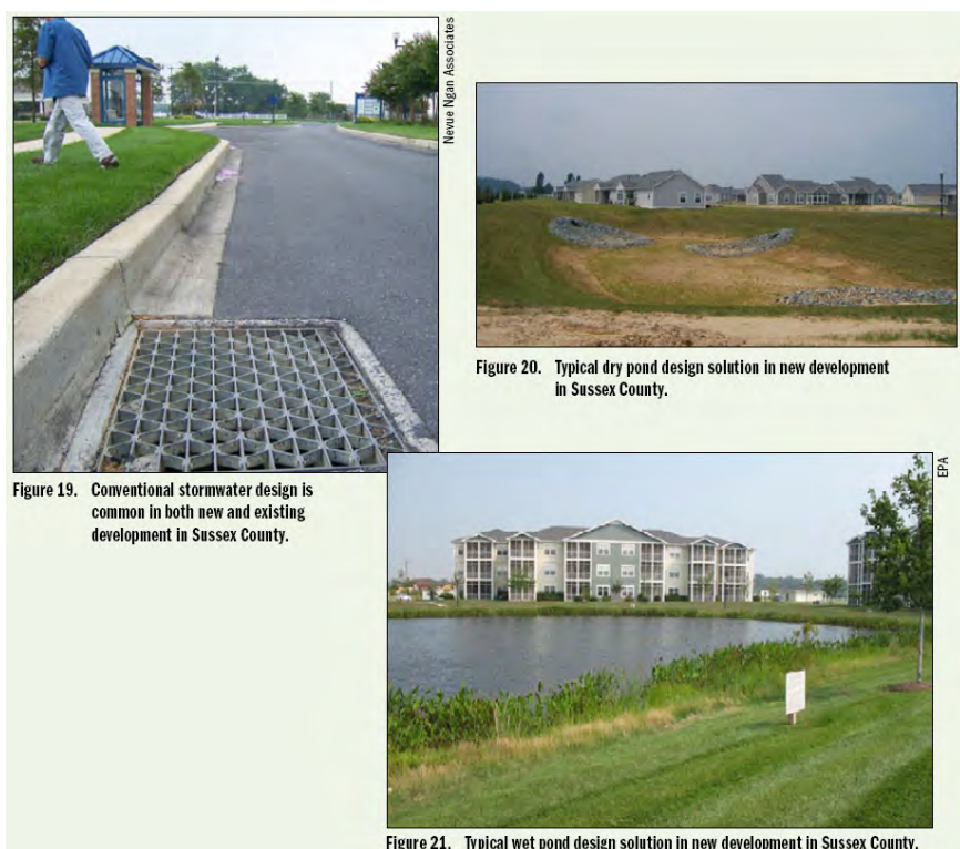
Figura 6-6. Alcune soluzioni adottate per la gestione delle acque meteoriche di dilavamento stradale (Fonte: EPA-NOAA "Smart Growth Implementation Assistance for Coastal Communities For Sussex County, Delaware", 2009).
