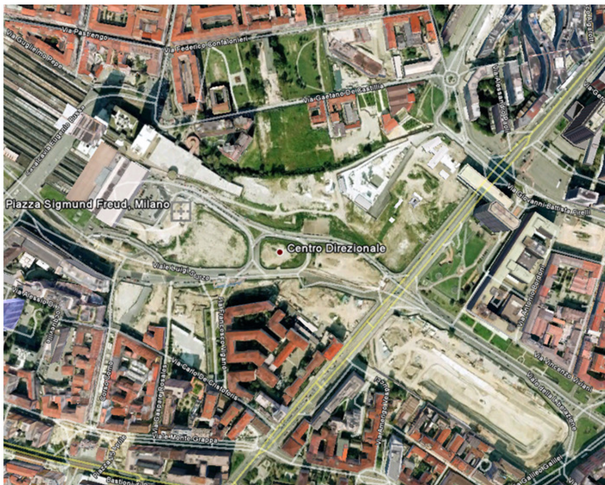
Figura 5.2-1: vista aerea dello stato di fatto precedente l'inizio lavori del PII – area locale
