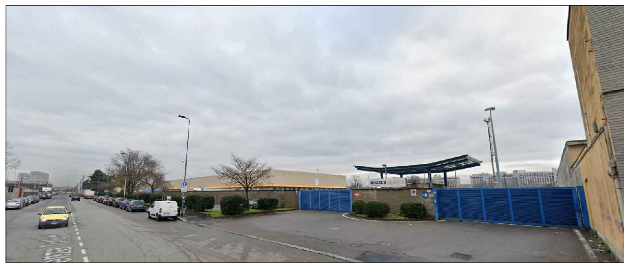
VISTA 1 - DEPOSITO AMAZON
